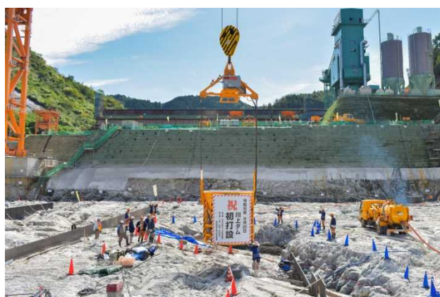
コンクリート投入
